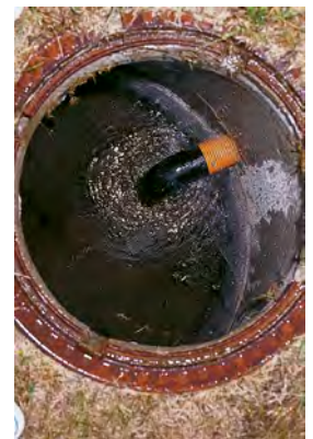
Abb.: Schacht aus Beton
