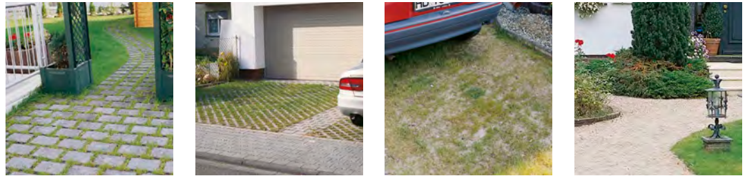
Abb.: Verschiedene durchlässige Flächenbefestigungen.
