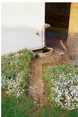
Abb. oben: Regenwasserversickerung in einer Mulde.
