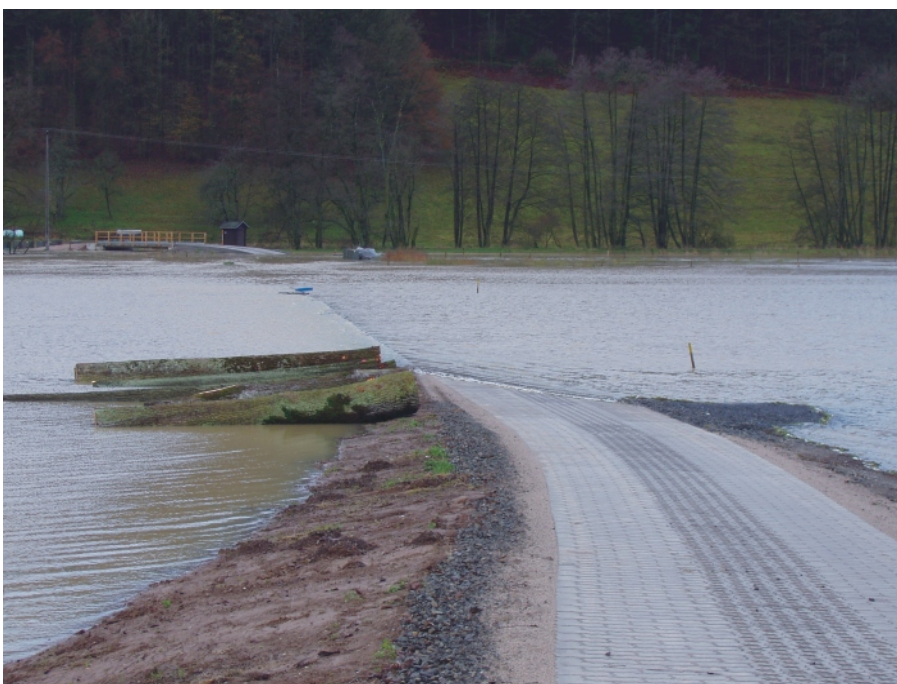
◀ Hochwasser im Januar 2003, überfluteter Wirtschaftsweg südlich von Horb a. d. Steinach
