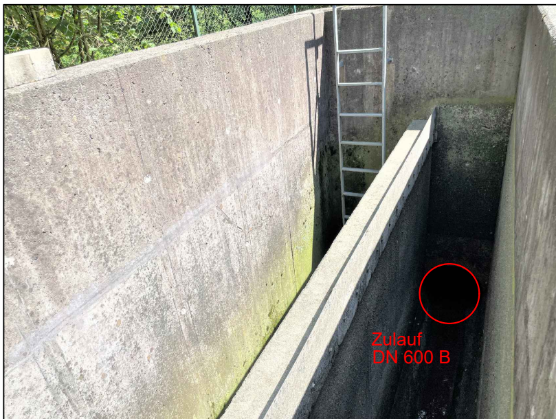
Abb. 1 Trennbauwerk Blickrichtung Einstieg/Zulauf
