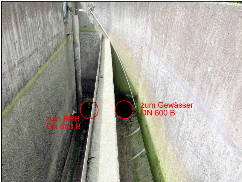
Abb. 2 Trennbauwerk Blickrichtung Ablauf RRB/Gewässer
