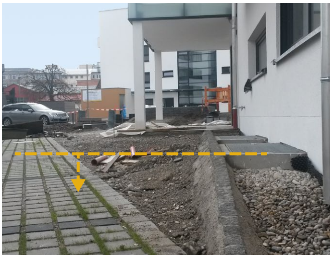
Abb. 10: Zum Schutz vor Überflutungen in Folge von Starkregen sollten unter anderem Lichtschachtöffnungen über das Niveau des umliegenden Geländes angehoben werden (links). Beispielsweise in Innenhöfen kann zusätzliches Retentionsvolumen in Kombination mit Versickerungsmulden geschaffen werden (rechts).
