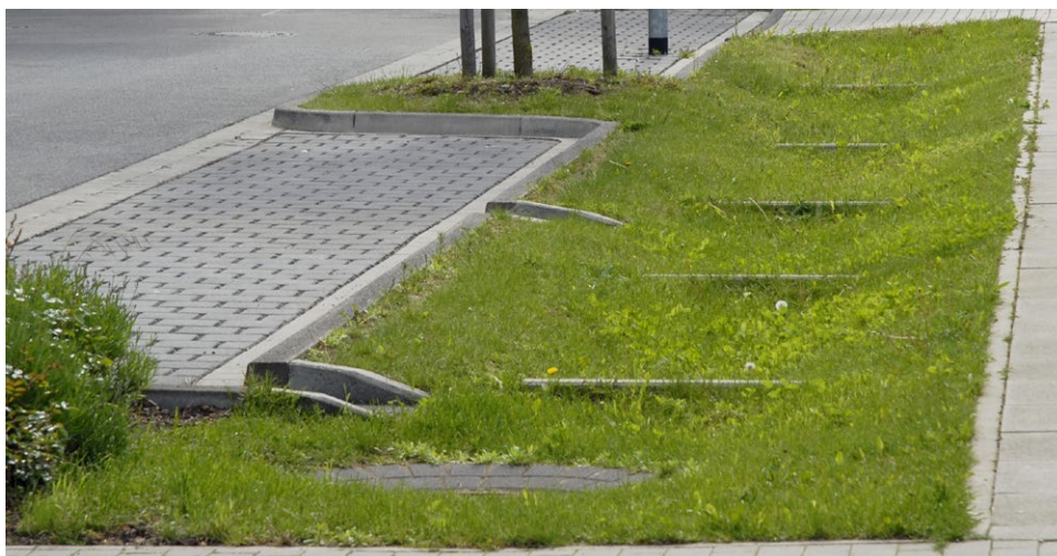
Abb. 7 Die Versickerung von gesammeltem Regenwasser in einer Mulde ist den natürlichen Verhältnissen am ähnlichsten.
