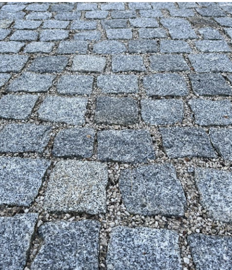
Abb. 4: Durchlässige Flächenbefestigungen erlauben es, den natürlichen Wasserkreislauf teilweise zu erhalten. Beispiele sind Natursteinpflaster mit Splittfugen (links). Auch unter Terrassen aus Holzdielen (Mitte) kann Regenwasser versickern. Befestigungen mit Vegetation, wie Rasengittersteine (rechts), sind den natürlichen Verhältnissen am ähnlichsten.
