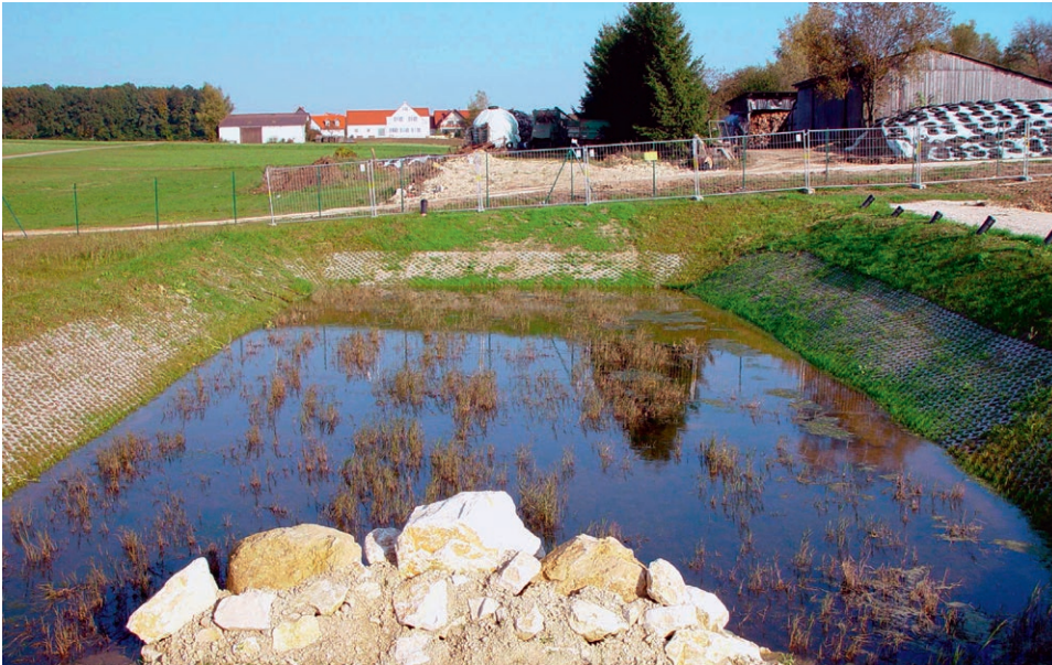
Abb. 12: Hier wird Regenwasser in einer Bodenfilteranlage zurückgehalten und gereinigt.
