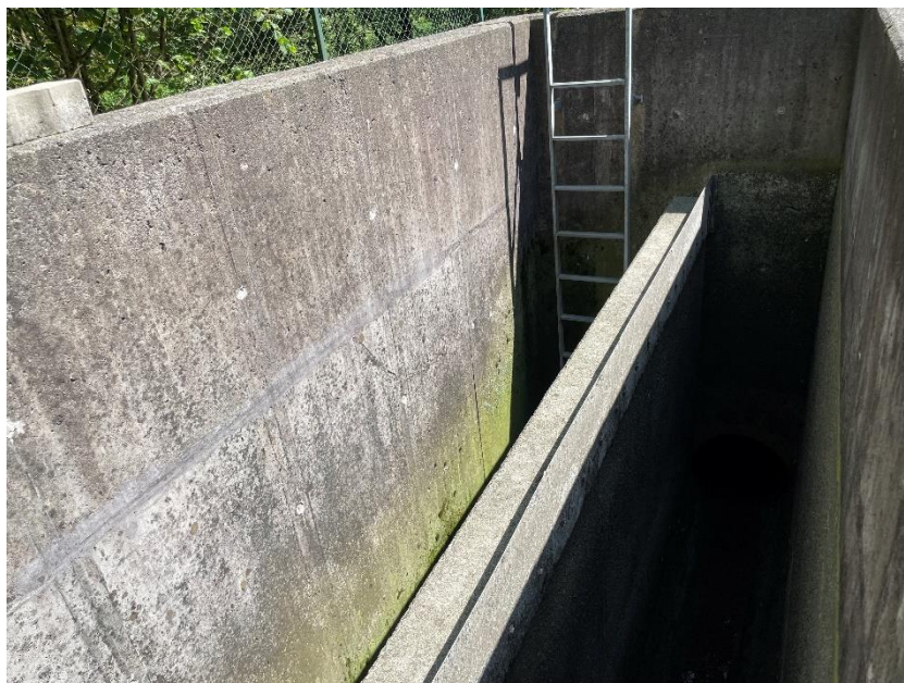
Abbildung 1-5: Schwelle mit Tauchwand
