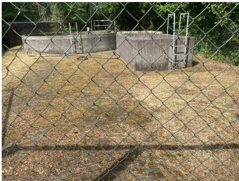
Abbildung 1-2: Lage auf dem Kläranlagengelände
