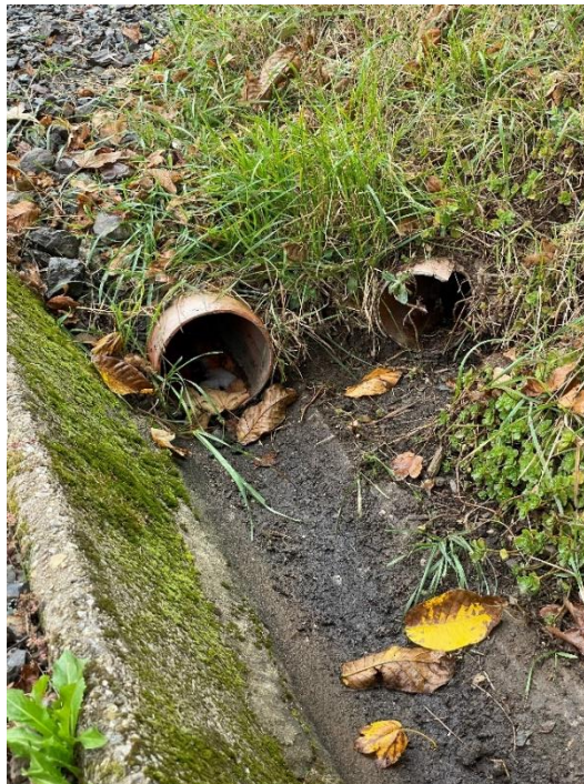
Abbildung 3-1: Einleitungsstelle 1 in den Rössenbach
