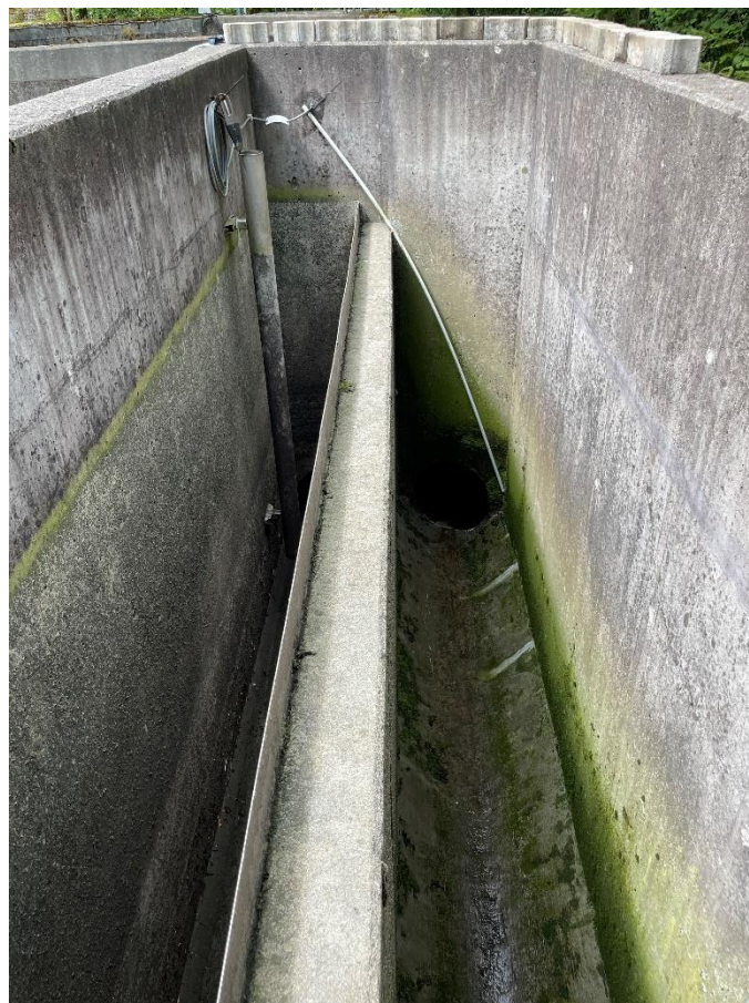
Abbildung 1-7: links: DN 600 zum RÜB / rechts: Entlastungsleitung DN 600 zum Gewässerrechts
