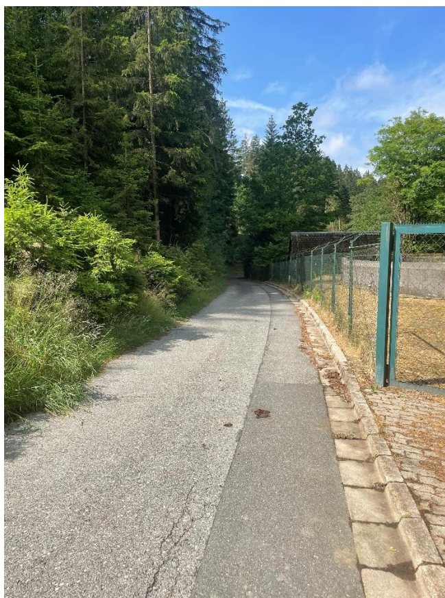
Abbildung 1-3: Zufahrt zum Regenüberlaufbecken und Entlastungsbauwerk
