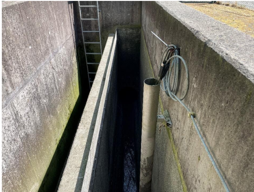
Abbildung 1-6: Zulauf rechts DN 600 Mischwasserkanal
