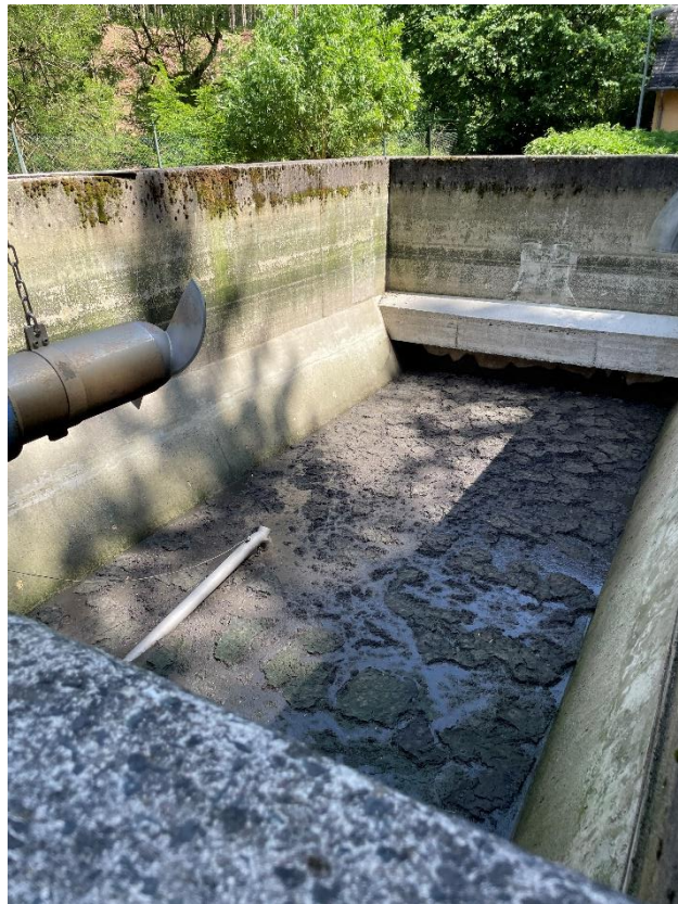
Abbildung 2-15: alte Kläranlage wird als Speicherbecken genutzt
