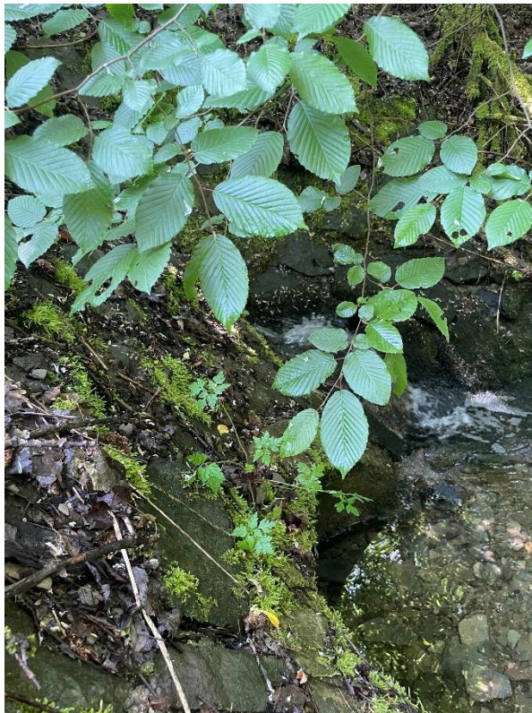
Abbildung 2-12: Einleitstelle Kläranlage und Bachverrohrung
