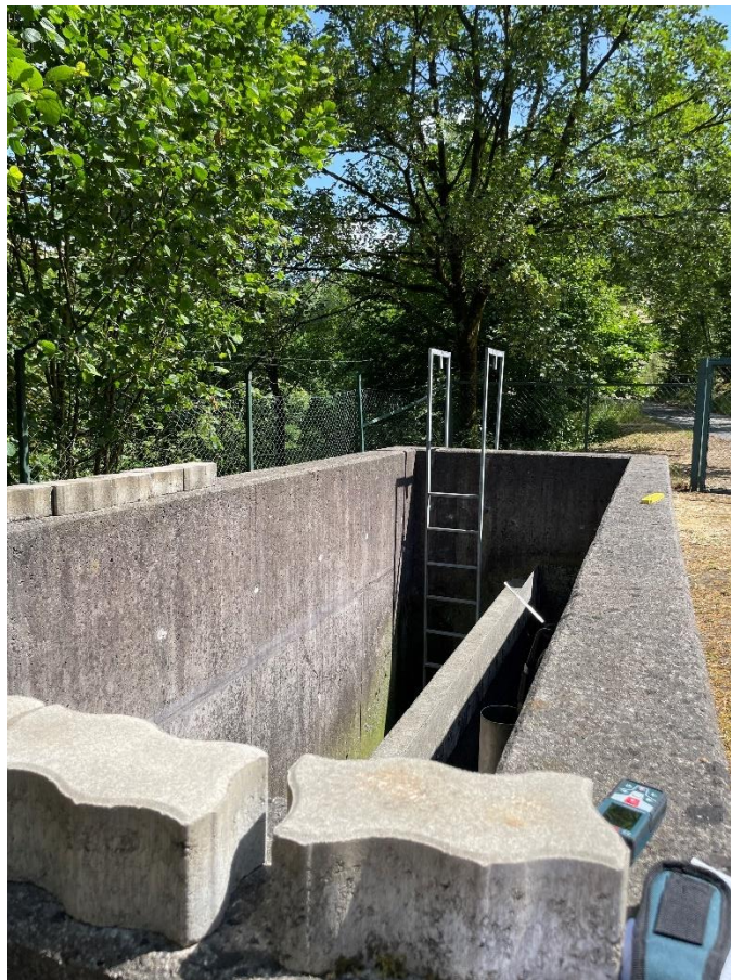
Abbildung 1-4: Entlastungsbauwerk
