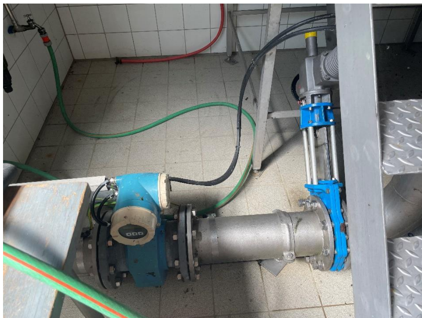
Abbildung 2-4: Zuflussregelung
