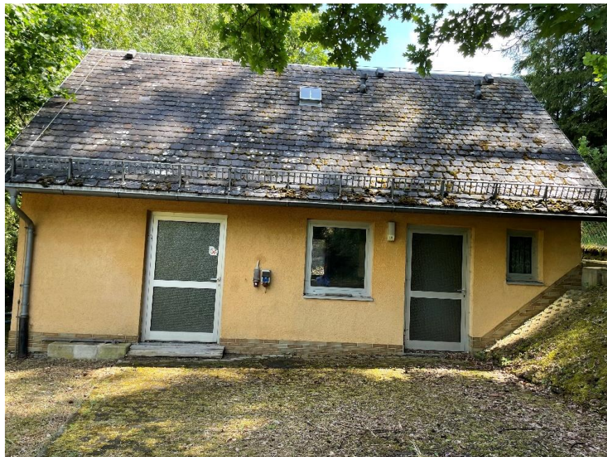
Abbildung 2-16: altes Betriebsgebäude wird als Werkstatt genutzt
