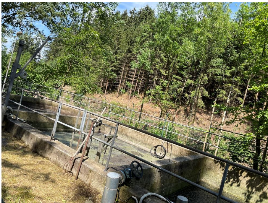
Abbildung 2-14: Schlammepolder
