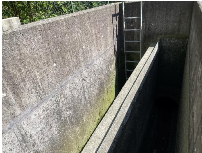
Abbildung 5-1: Trennbauwerk mit Tauchwand
