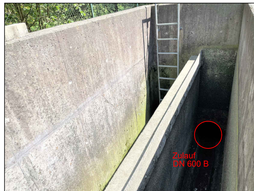
Abb. 1 Trennbauwerk Blickrichtung Einstieg/Zulauf
