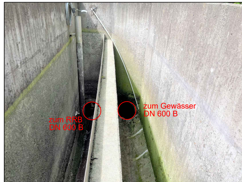
Abb. 2 Trennbauwerk Blickrichtung Ablauf RRB/Gewässer
