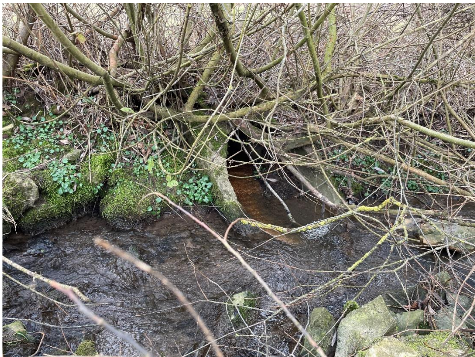
Abbildung-1: Einleitstelle Entlastungskanal in Krebsbach
