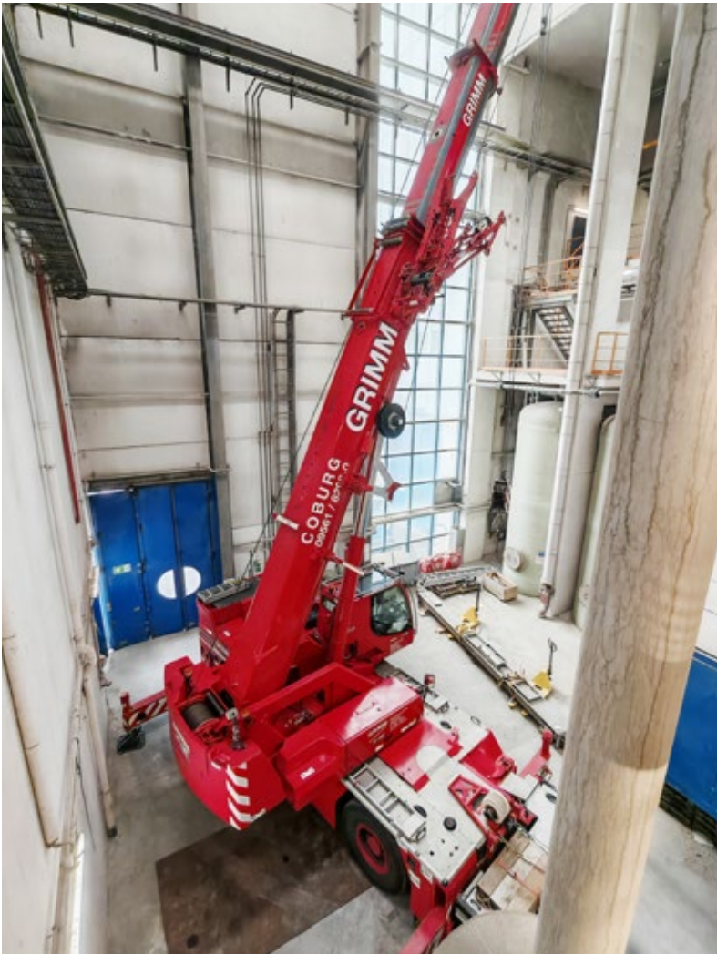
Im Kesselhaus wurde mittels Autokran eine schadhafte Förderschnecke ausgetauscht.
