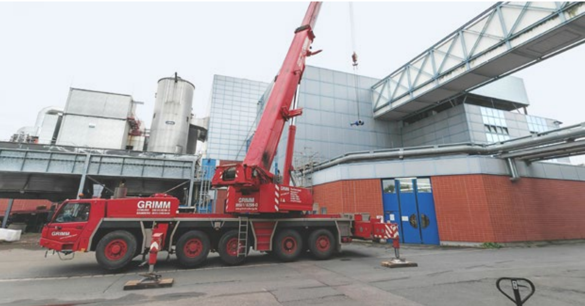
Mittels Autokran wurde ein neuer, 350 kg schwerer, Absperrschieber in den Leitungen der Fernwärme verbaut.
