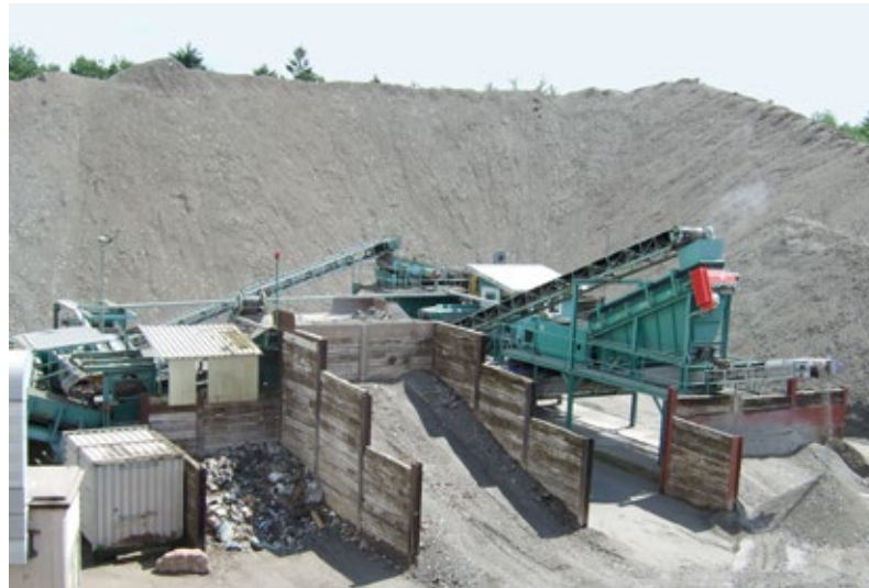
Die Schlackeaufbereitungsanlage siebt Metalle ab und reinigt die Rohschlacke.
