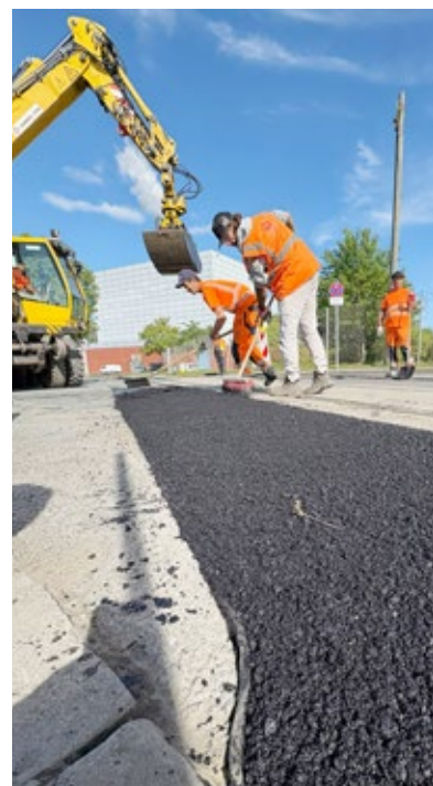
Asphaltarbeiten am Bahnübergang Glender Straße.
