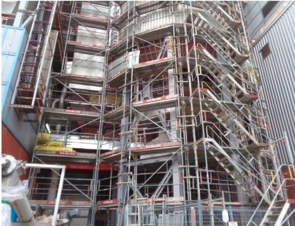
Für die Erneuerung der Begleitheizung musste der Sprühabsorber komplett eingerüstet werden
