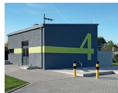
4. Reinigungsstufe Kläranlage Weißenburg
