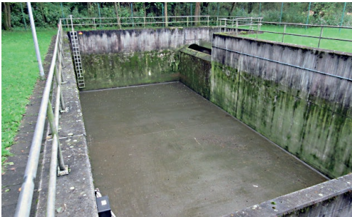
Bild oben: Regenüberlaufbecken mit Blick auf den Ablaufbereich
