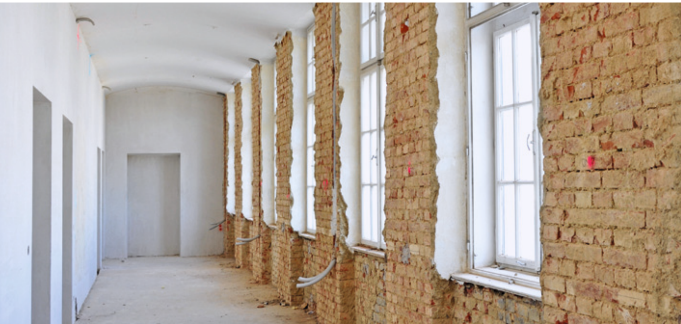
Entfernter Putz zur besseren Trocknung einer Außenwand
