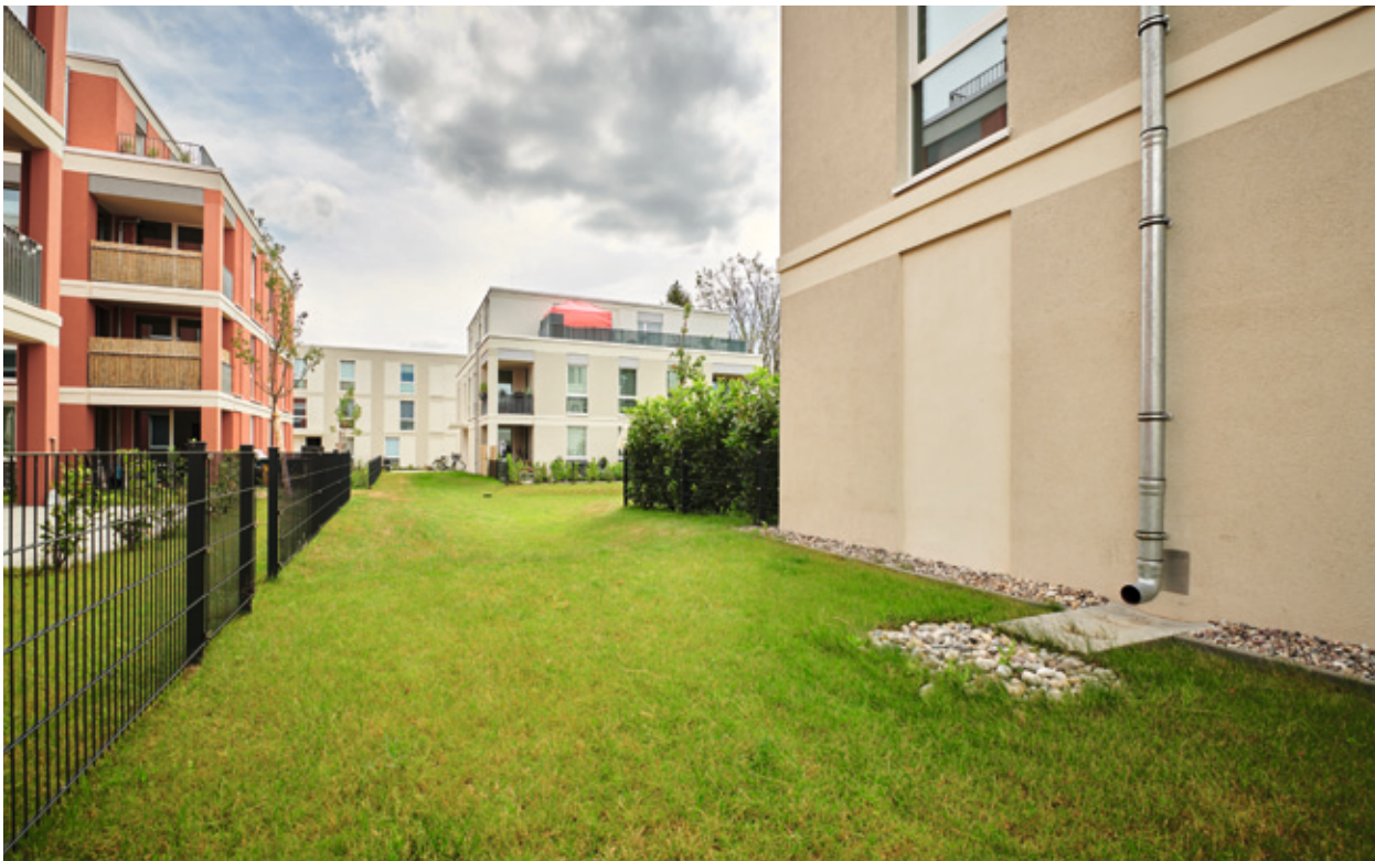
Dezentrale Rückhaltung von Niederschlagswasser
