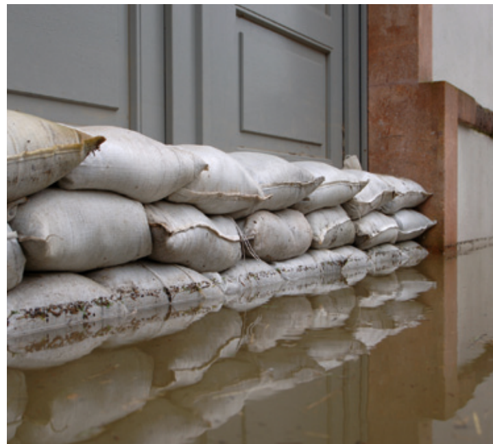
Notfallmäßiger Objektschutz mit Sandsäcken
