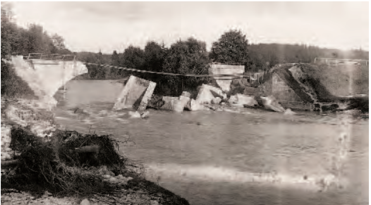
Reste der Traunbrücke bei Hörpoltling nach dem Hochwasser im September 1899
