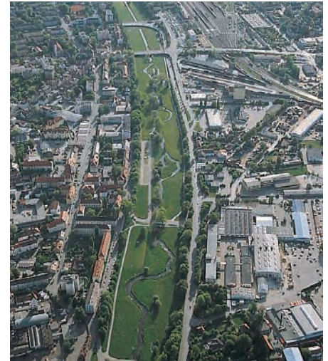
Die Flutmulde der Isar bei Landshut leitet das Hochwasser um den Stadtkern.
