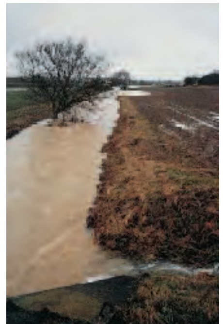
Dieser Bach wurde – wie eine Vielzahl anderer Bäche – im Zuge der Flurbereinigung in den 50er- und 60er-Jahren ausgebaut. Er tritt auch bei hoher Wasserführung kaum mehr über die Ufer und führt
