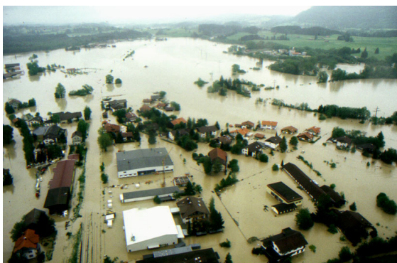
Bebauung im Überschwemmungsgebiet
