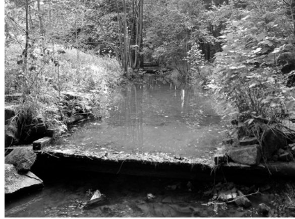
Erhaltene hölzerne Sohlschanzenkonstruktion an der Langenau.
