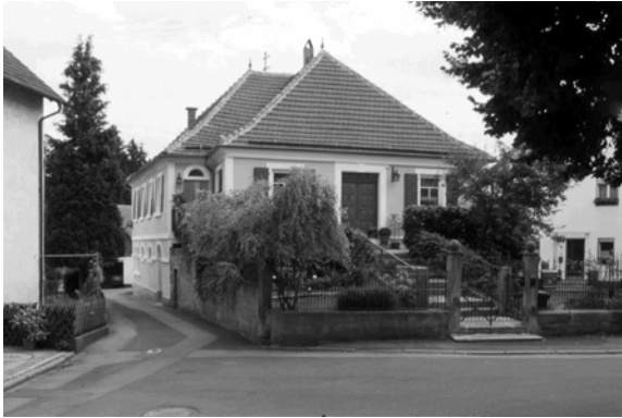
Floßherrenhaus Kirchplatz 15 in Unterrodach. Den jüngeren Anbau zum Platz hin errichtete Peter Eber Petersohn, Sohn von Peter Eber, dem Gründer der Unterrodacher Floßherrndynastie Eber.
