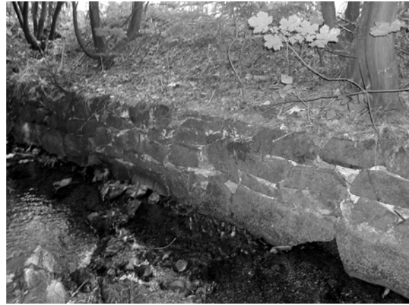
Senkrechte Ufermauer an der Langenau.
