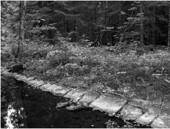
Uferpflasterung an der Langenau – in der unteren Pflasterreihe liegen besonders große Steine.
