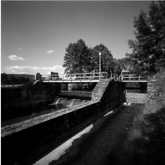
Trommelwehr mit betonierter Floßgasse von 1908 am „Schulbau“ in Küps. Während der großen Rodachregulierung von Küps erbaut, ist es eines der ältesten erhaltenen Wehre seiner Bauart.
