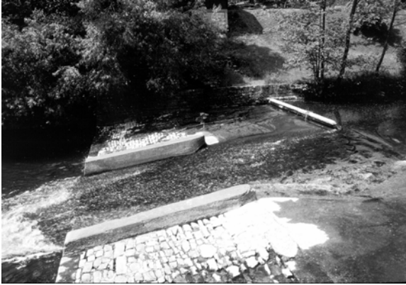
Der Weltbau in Unterrodach als große Sohlschwelle in Stein- und Betonbauweise (ca. 1948).
