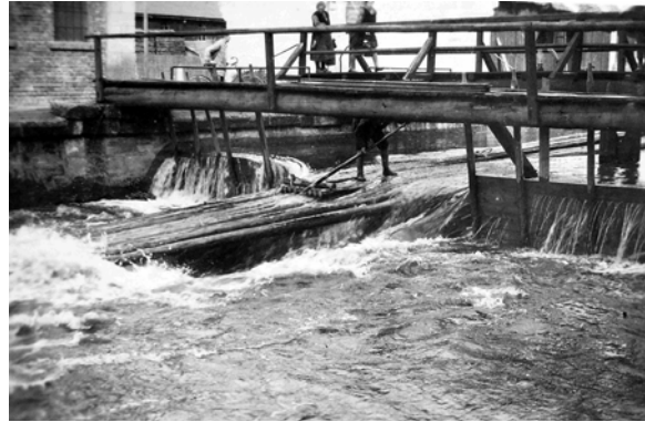
Auf diesem Foto einer Floßdurchfahrt durch das Herrenwehr in Kronach ist deutlich das System der Wehröffnung zu erkennen. Die Wehrleisten wurden kurz vor der Floßdurchfahrt herausgenommen und auf dem Wehrsteg abgelegt.
