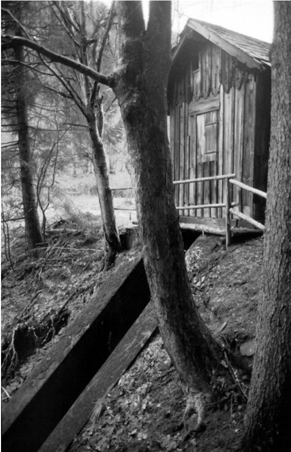
Das Teichzieherhäuschen über dem Auslauf des Lamitzteiches.
