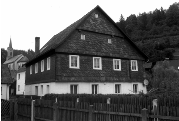
Mühlgraben 17 in Wallenfels – ein Floßherrenhaus des 18. Jahrhunderts.
